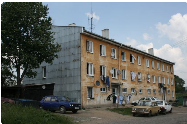
Prostor před panelovým domem
